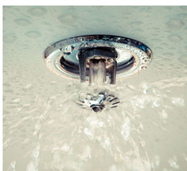
水道連結型自動撒水設備
